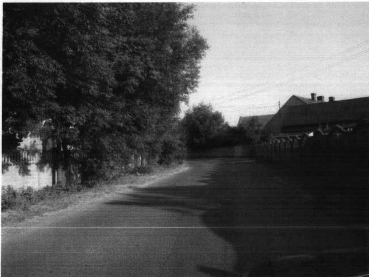
Zdjęcie 2. Niebezpieczny przebieg drogi powiatowej przez miejscowość (ciasny, zły nawierzchni i pełen zakrętów)
