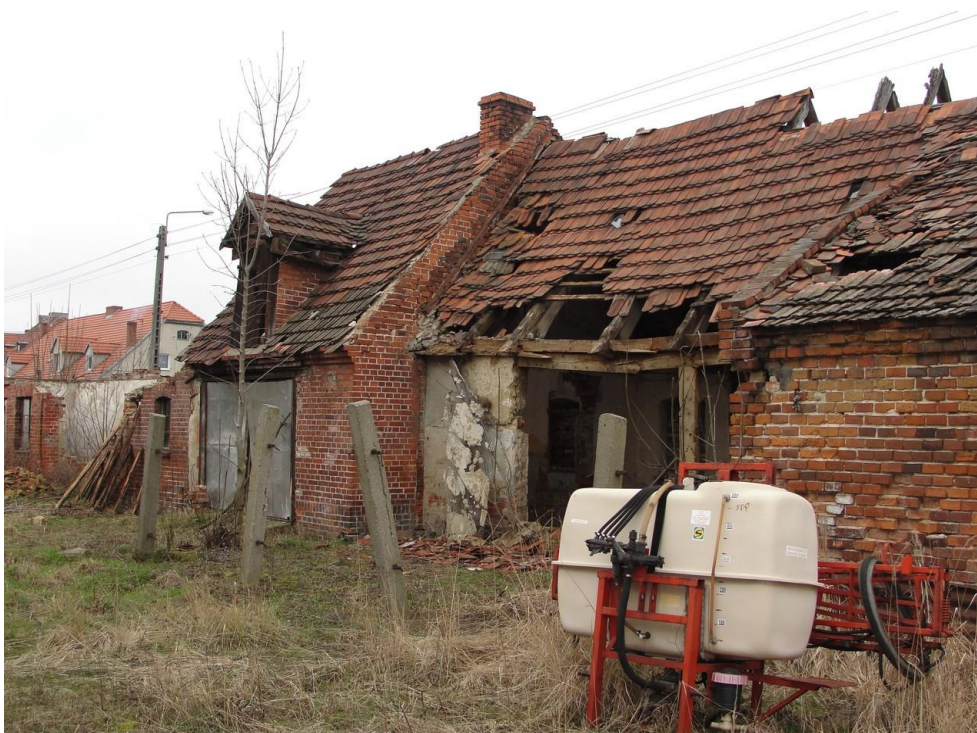
Fot. 8 – Zdegradowana konstrukcja dachu grożąca katastrofą budowlaną
