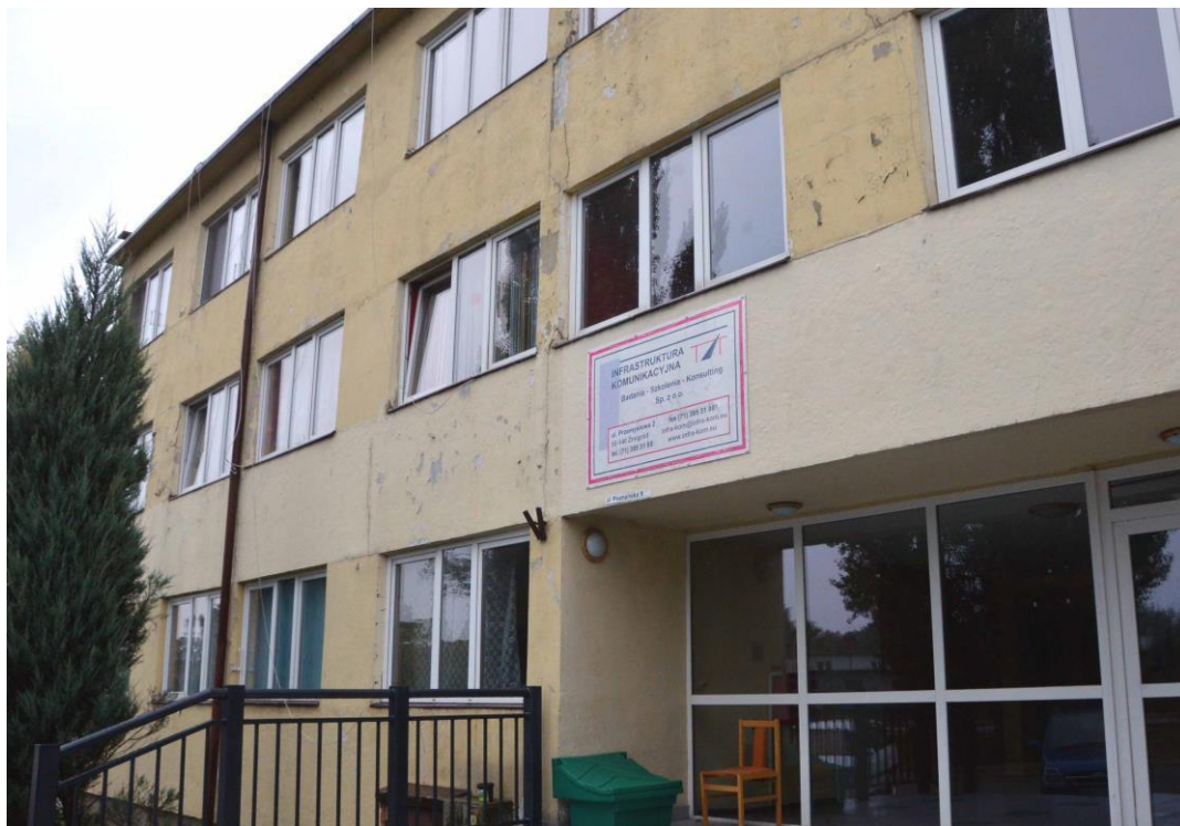
Ryc. 2. Widok na elewację od strony głównego wejścia.
