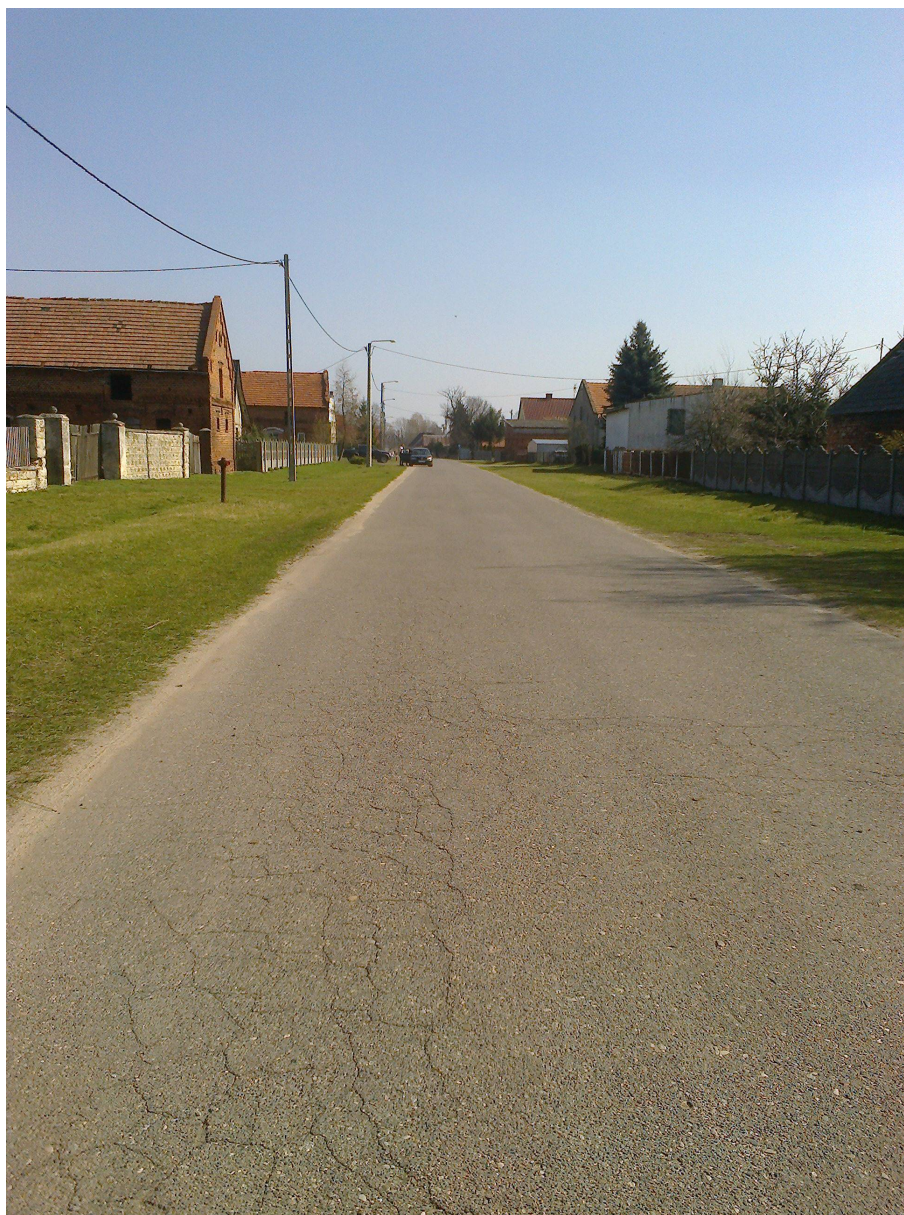
Fot. Nr 1 lokalne spękanie nawierzchni w m. Sanie
