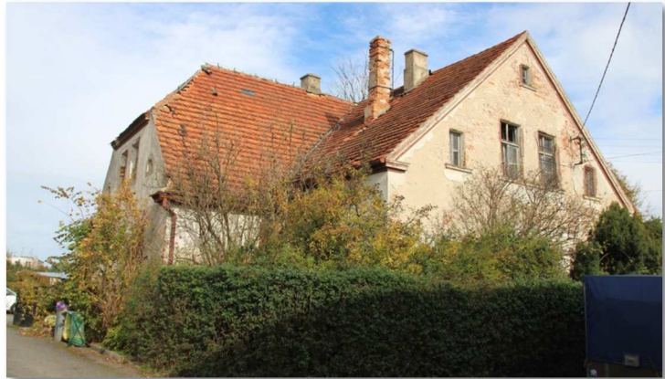
nieużytkowany budynek mieszkalny; dawna leśniczówka (widok od podwórza)
