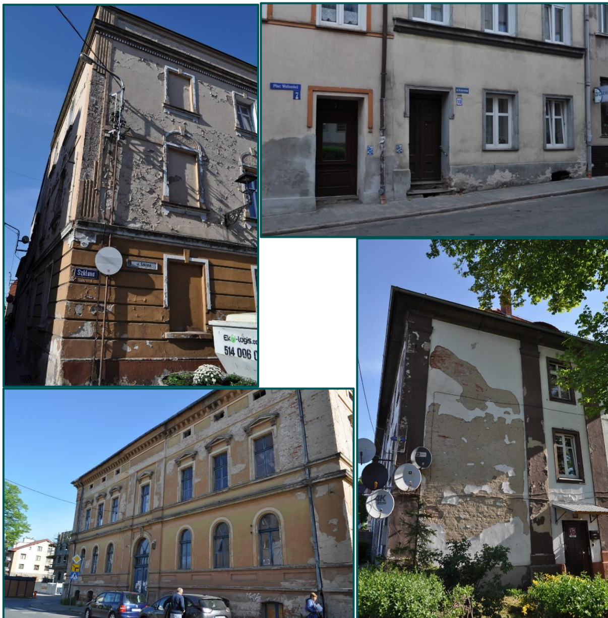
Rysunek 13. Stan elewacji wybranych kamienic w centrum Żmigrodu.
