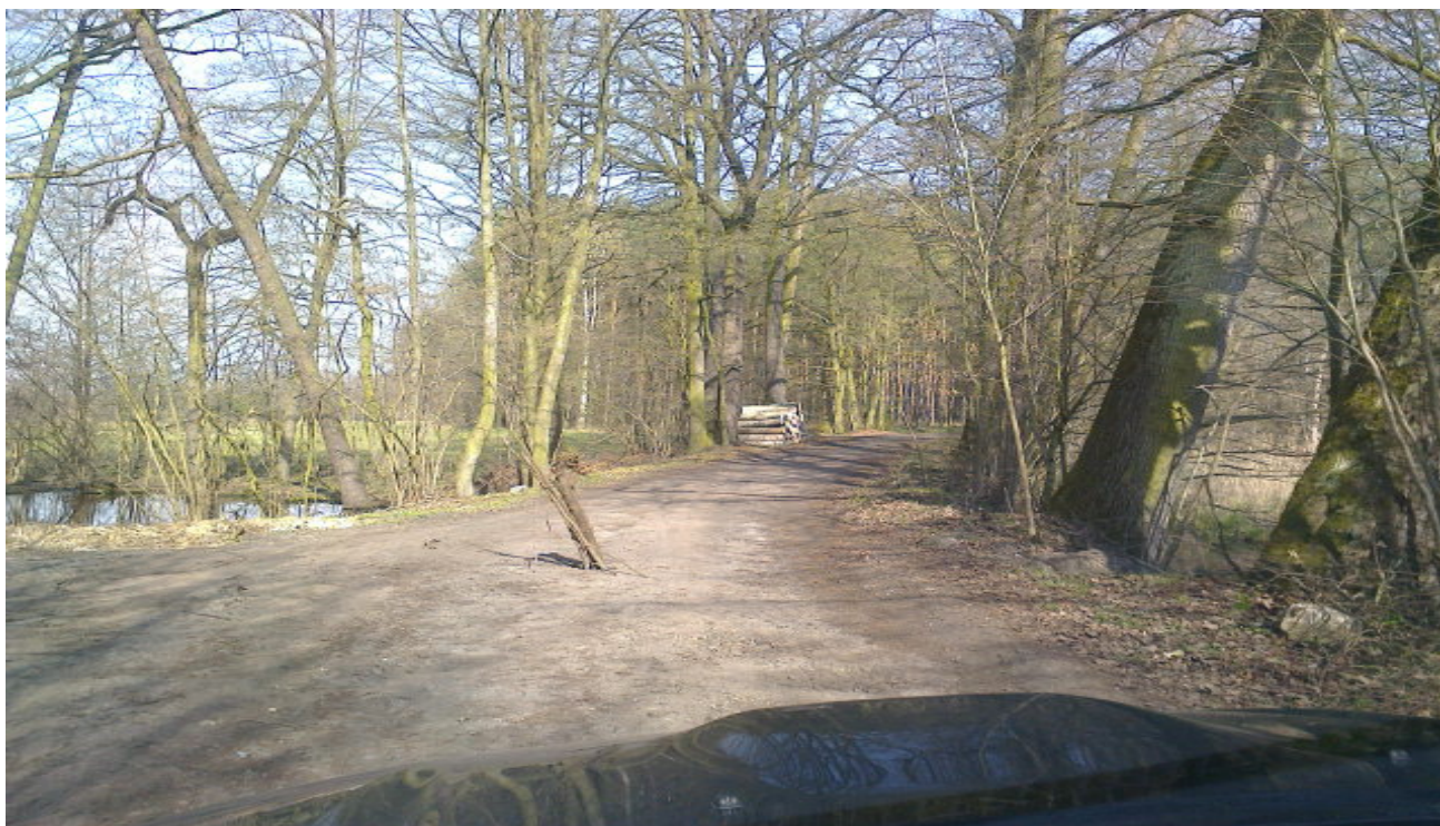
Fot . Oznakowanie wyrwy na przepuści fi 1000 – widoczne gałęzie włożone w ubytek .
