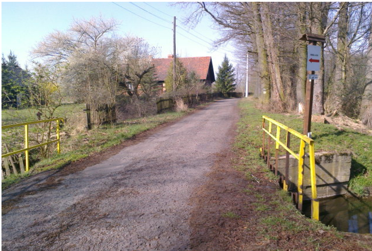
Fot. Istniejące oporęczowanie mostu do wymiany .
